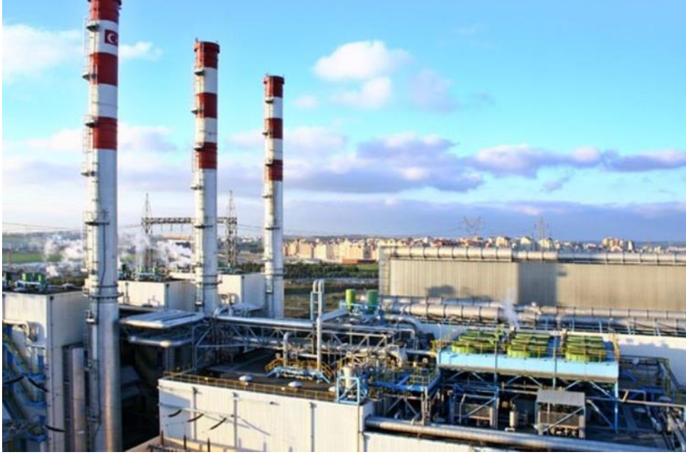
Şekil 11. Esenyurt Kojenerasyon Santrali [6]
